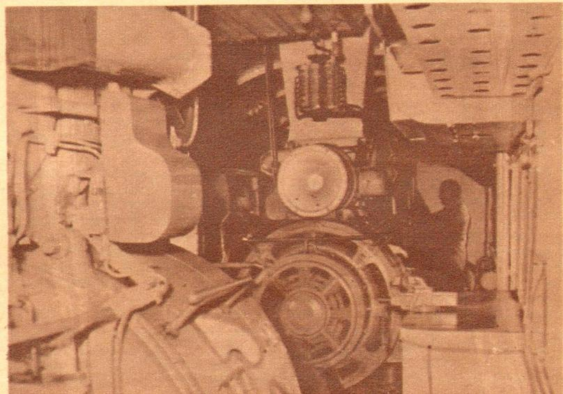
Perspectivas de dos de los cuatro motores diésel que producen la energía eléctrica de la "Argentina". Nótese la amplitud de los espacios para el movimiento de los mecánicos y electricistas.
