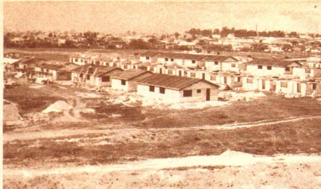
Merced a la pujante acción del Gobierno Justicialista, muchos bañados y terrenos baldíos del partido 4 de Junio se han transformado en magníficos barrios obreros.
